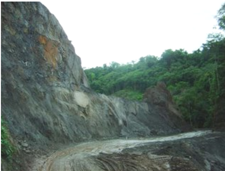
Foto. 4. Carretera entre Masuko y Puente Inambari.
