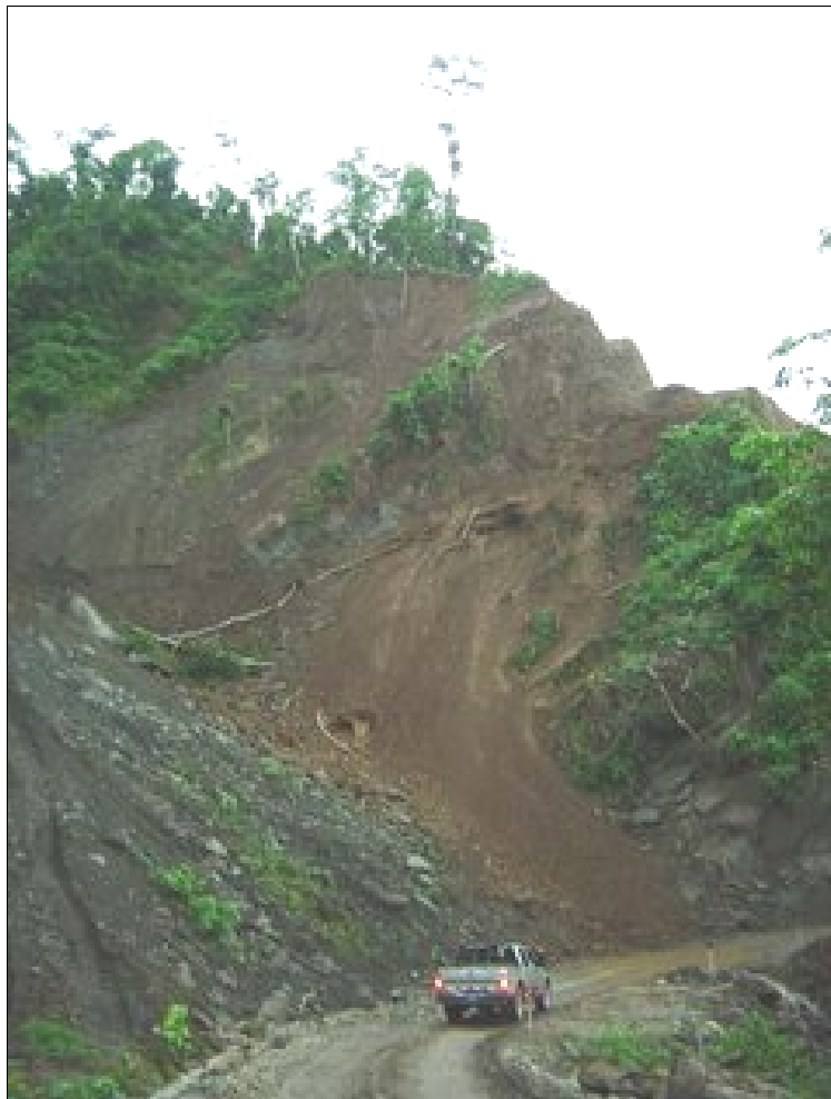
Foto. 1. Tramo de la carretera Interoceánica Sur
