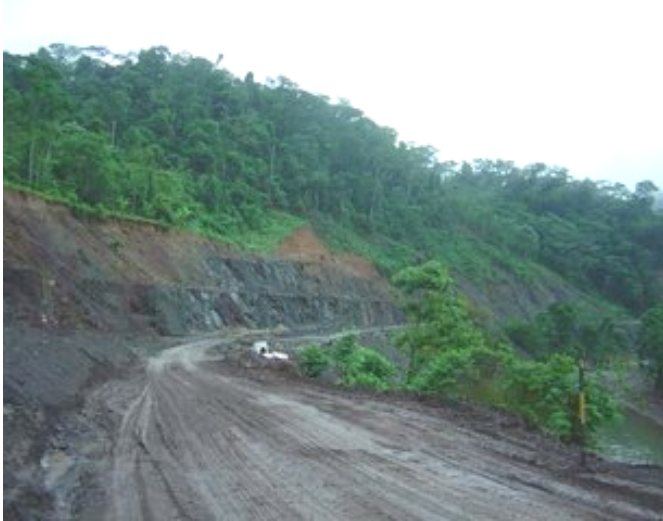
Foto 2. Tramo carretera Km 15.
